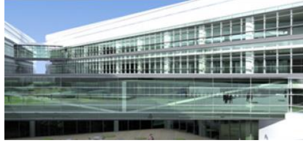
Sancaktepe Mühendislik Merkezi (2015)
